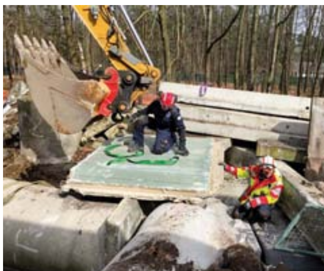
I·S·A·R Germany Helfer beim Einbau einer schweren Betonplatte auf dem Übungsgelände der Training-Base Weeze
